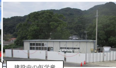
建設中の仮学童
