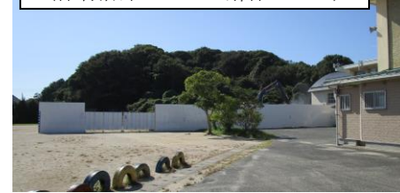
現在の運動場仮囲いの様子 (体育倉庫とプール解体のため)
